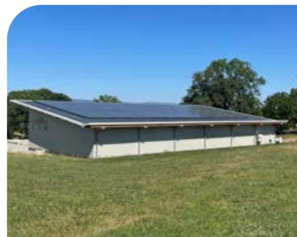
La commune de Saint-Maurice a souhaité mettre en place 300 m<sup>2</sup> de panneaux photo-voltaïques sur le Centre Technique Municipal récemment construit car un nouveau dispositif appelé «Auto-Consommation Collective» permet de produire de l'électricité sur un site et de l'utiliser sur d'autres bâtiments.
